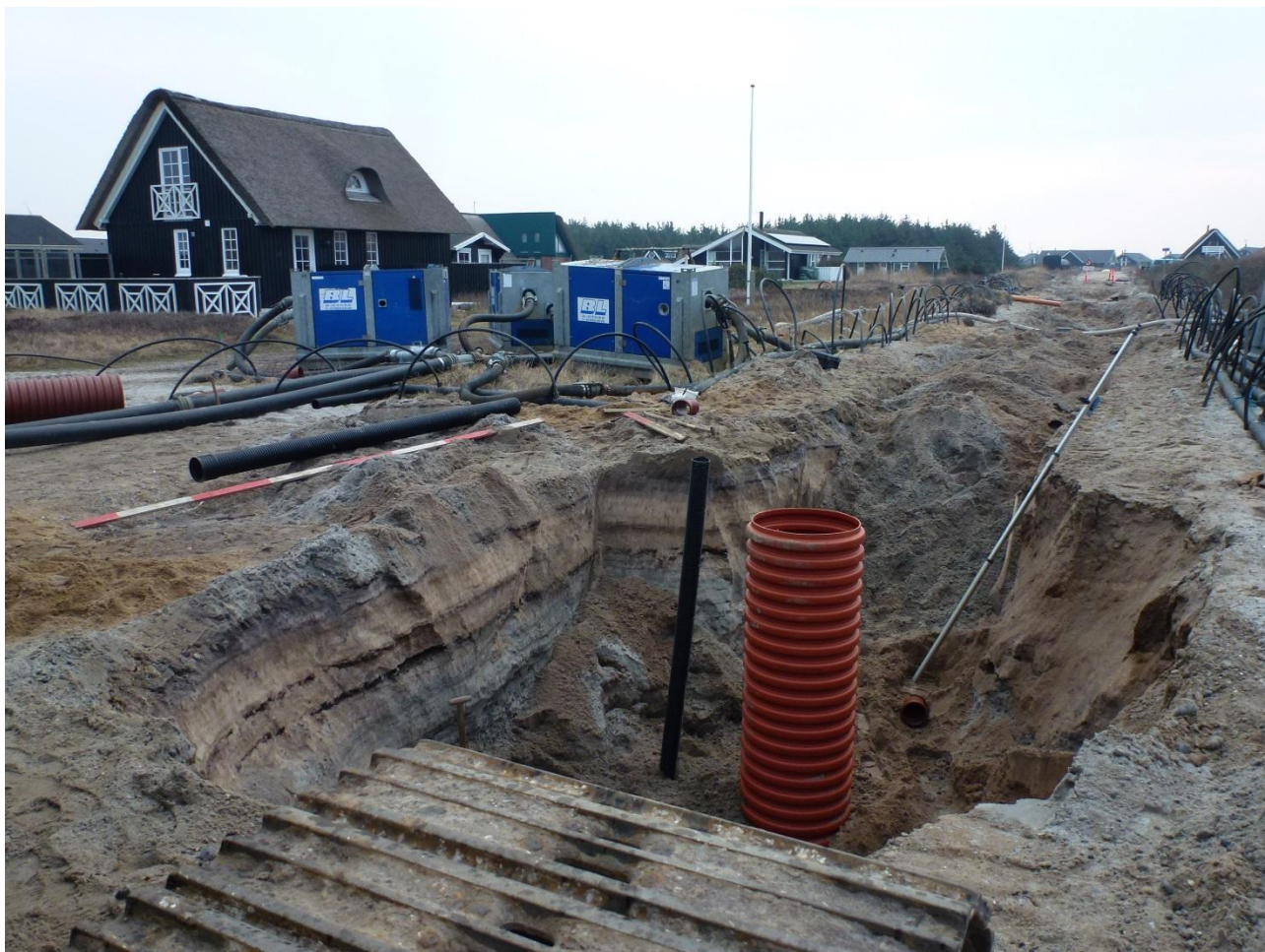
Foto fra Fourmivej den 26. feb. 2014.
