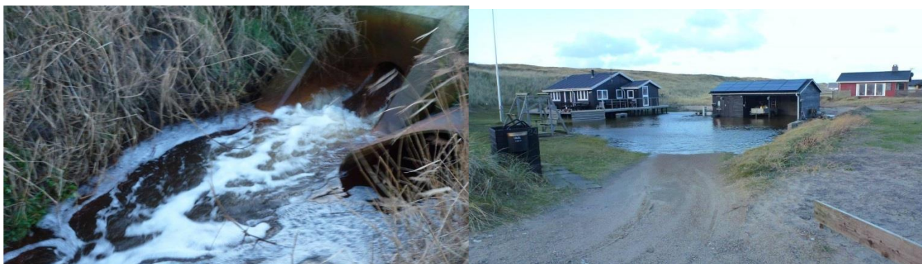
Afløb fra hovedpumpestation den 30.11.2015
